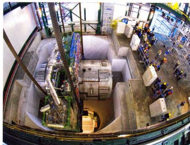
Der zentrale Teil des CMS-Detektors wird mit einem Spezialkran zum Einsatzort in die Tiefe gehievt.
